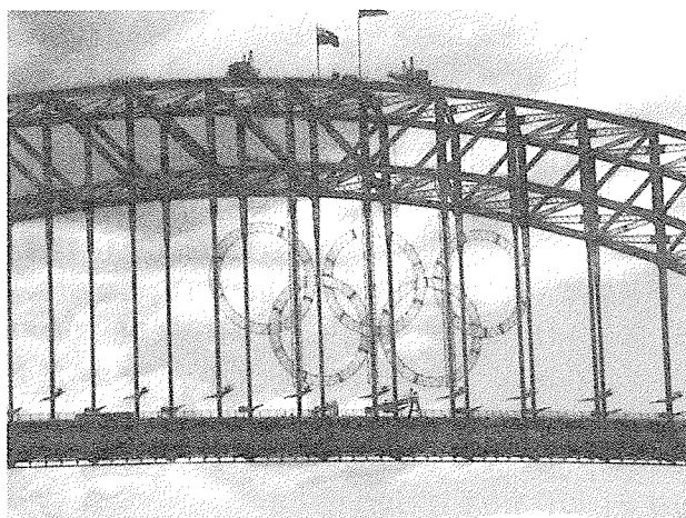
写真1 メインアーチ上を移動するメンテナンス作業車 (撮影：山崎利文, 2000.9.9)
