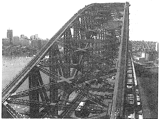
写真4 南岸のパイロン頂上からブリッジ・クライミングルートを望む (撮影：山崎利文, 2000. 9. 9)
