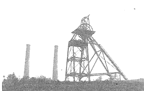
写真-2 建設位置に保存されている第一竪坑 及び煙突（撮影：長弘，1992.3.14）
