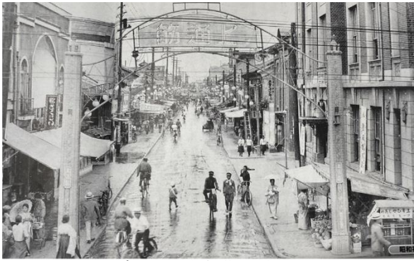
写真-1 昭和初期の上通入口 (熊本市今昔写真帖より)
