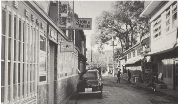
写真-3 昭和33年の旧第一高等学校前の通り (熊本市今昔写真帖より)
