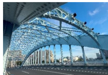
写真-5 橋門および上横構
