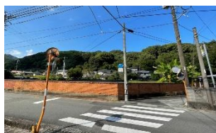
写真-4 レンガ塀/電柱
