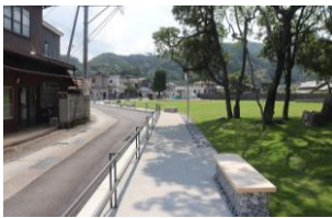
写真-6 広場南側道路
