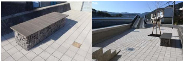
図-12 整備前の護岸石材を詰め込んだじゃかごベンチ
