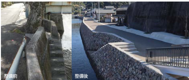
図-6 防滑性と親水性を考慮した階段工の整備
