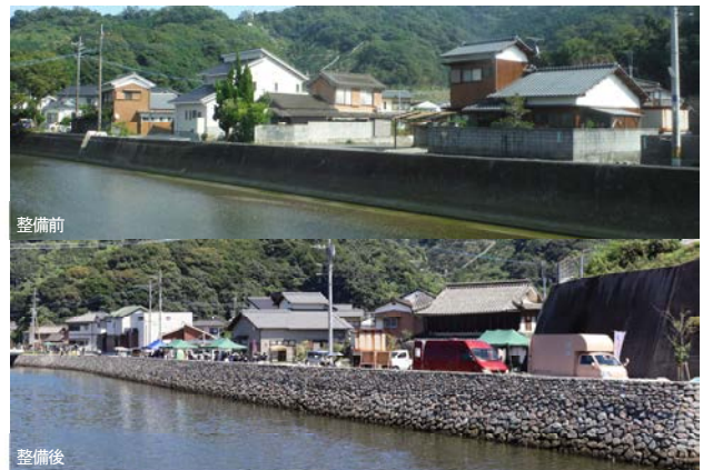
図-3 整備前のコンクリート護岸と整備後の練石積護岸
