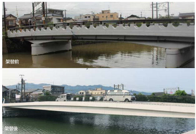
図-10 架替前後の新港橋
