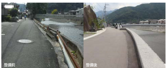
図-5 着座可能なパラペットの新設
