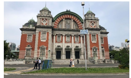
中之島通(公会堂前道路)の整備前
