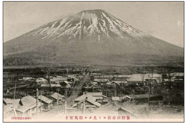
写真3『真狩別村街より見タル蝦夷富士』と題された絵葉書。電柱があり旧村名であることから大正11年以降昭和15年までの状況と考えられる(出典:北海道立図書館北方資料デジタルライブラリー)
