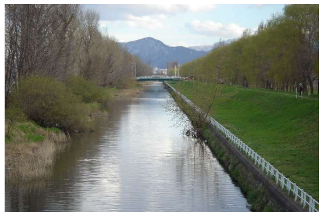
写真2 創成川の延伸、琴似茨戸約5km区間。明治19年、排水と舟運を目的に開削され、隣にその土砂を盛って石狩街道を建設した。計画者で建設事業を指揮したのは札幌農学校二期生の藤田九三郎である
