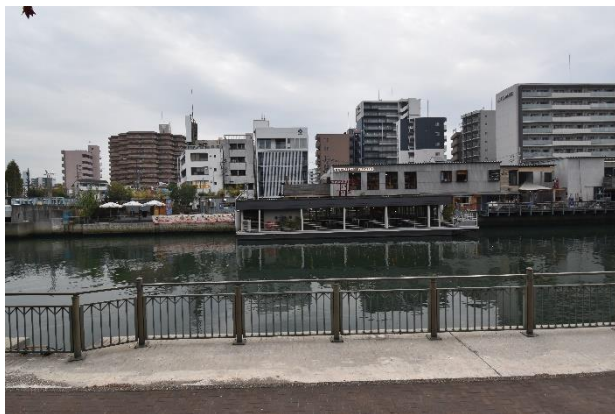
図3 船として許可された水上レストランは、厨房も船の上である。右手の建物に入る事業者も含めて避難訓練が行われる。（タグポート大正（大阪府大阪市））
