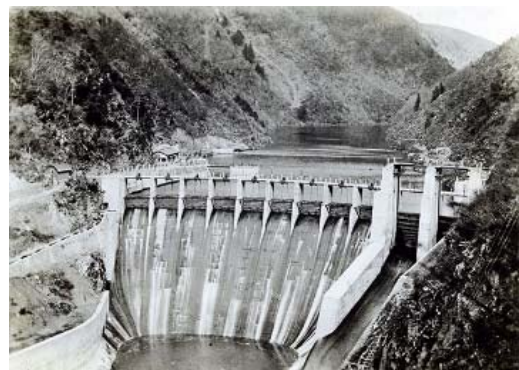
図-2 大峯堰堤竣工時の写真 3)
