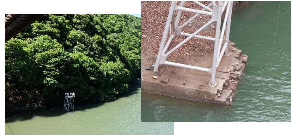
図-7 大峰堰堤の遺構写真
