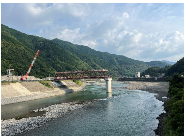
写真-16 上部工を架設中の坂本橋（令和6年6月11日撮影）
