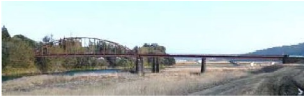
写真-11 ⑨天狗橋 (被災前)
