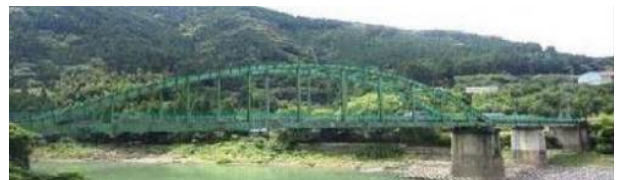
写真-5 ③鎌瀬橋(被災前)
