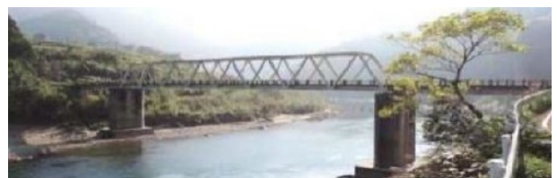
写真-7 ⑤大瀬橋(被災前)
