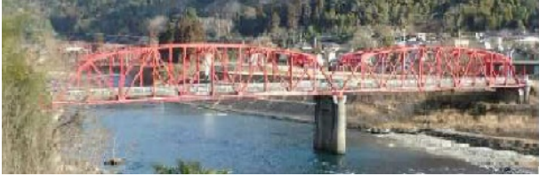
写真-9 ⑦相良橋 (被災前)
