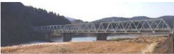
写真-12 ⑩西瀬橋 (被災前)
