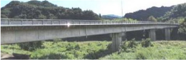
写真-10 ⑧沖鶴橋 (被災前)
