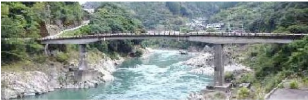
写真-8 ⑥松本橋 (被災前)
