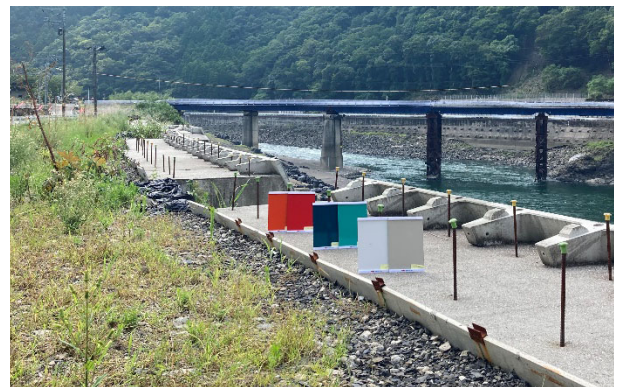
写真-14 塗装サンプル板を用いた色彩案の確認の様子
