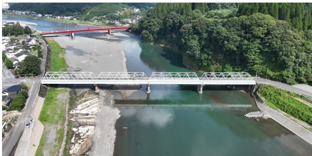
写真-15 新設橋の架け替えを終えた西瀬橋(出典：国土交通省八代復興事務所HP)
