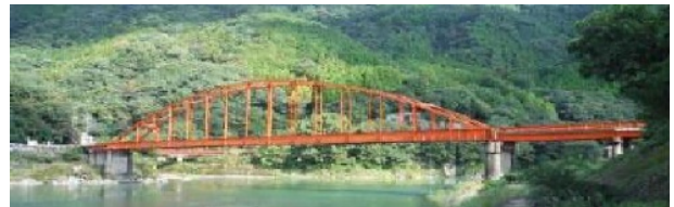
写真-3 ①深水橋(被災前)
