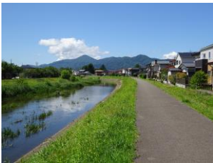
写真-8 G (撮影箇所⑦)
