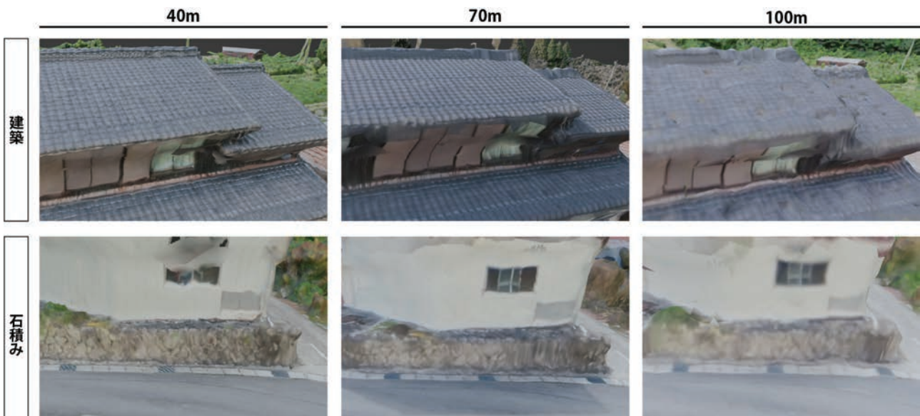
図-5 建築および石積みのメッシュの比較 (撮影高度：40m, 70m, 100m)
