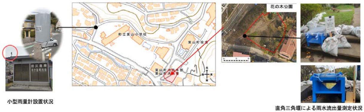
図-8 直角三角堰と小型雨量計の設置状況
