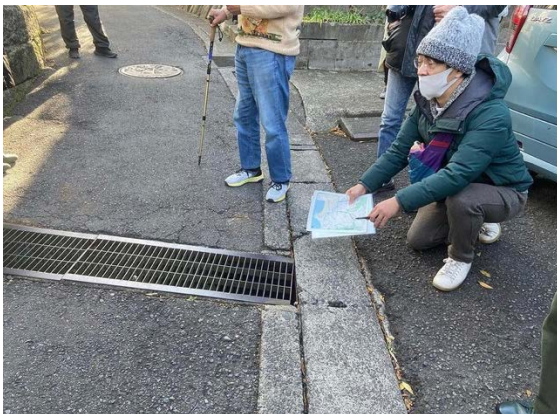
図-6 表流水が流下し溢水する「こみち」の横断側溝と縦断側溝の切り替え箇所。
