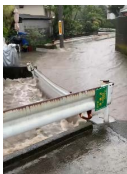
図-2 葉山町内の近年の土砂災害、浸水被害（2021年7月豪雨）。（左）堀内地区向原付近で発生した土砂災害、（右）森戸川流域堀内地区三家橋近くでの浸水被害。
