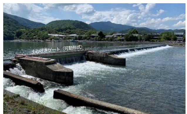
写真-5 現在の一の井堰 (土砂吐きゲートの堰柱は昭和26年当時のものを活用)
