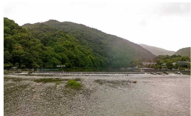
写真-8 流量：約 36\text{m}^3/\text{s} 、越流水深：約 24\text{cm} の落水表情 ※白波が消失
