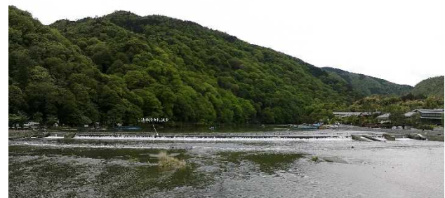
写真-7 流量：約 20\text{m}^3/\text{s} 、越流水深：約 16\text{cm} の落水表情 ※白波発生位置が徐々に低下
