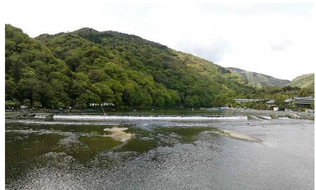
写真-6 流量：約 10\text{m}^3/\text{s} 、越流水深：約 10\text{cm} の落水表情 ※全面的に白波が発生
