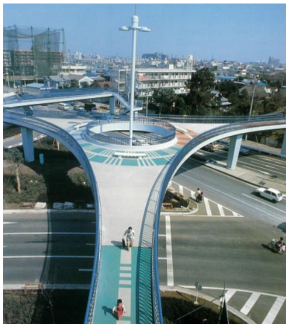
写真-1 蓮根歩道橋（建設当時） 10)
