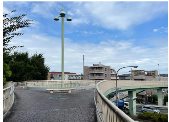
写真-3 蓮根歩道橋（改修工事後）
