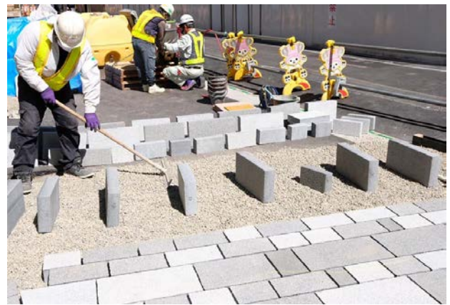
図8 舗装施工の様子
