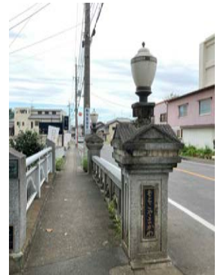
図-6 賀美橋の復元ランプ
