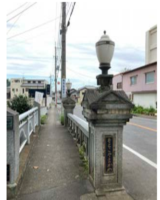
図-6 賀美橋の復元ランプ
