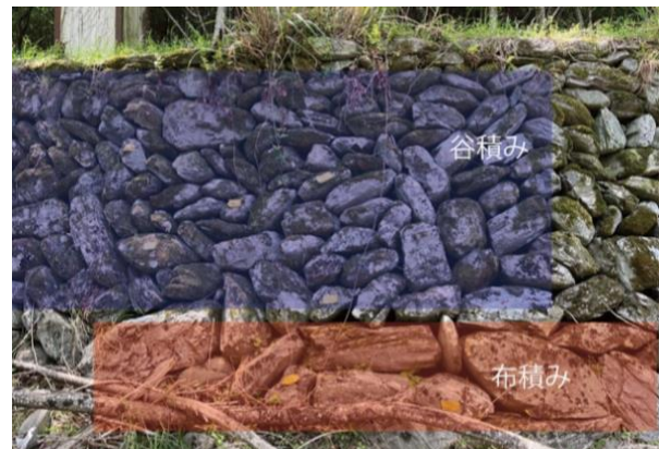
図-4 高さによる積み方の違い(7.川田川)
