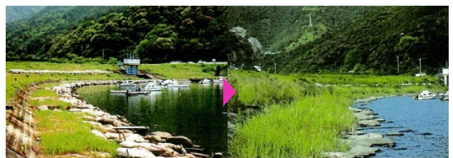
図-7 土の間詰直後(左)と植生回復後(右)
