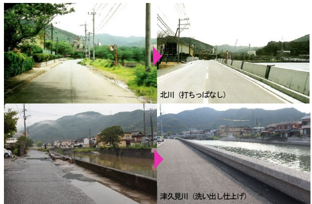
図-4 北川(1997)および津久見川(2017)築堤前後(津久見川は筆者撮影)
