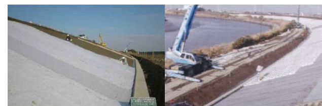
図-9 法覆被覆(左)と法覆護岸(右)の施工状況
