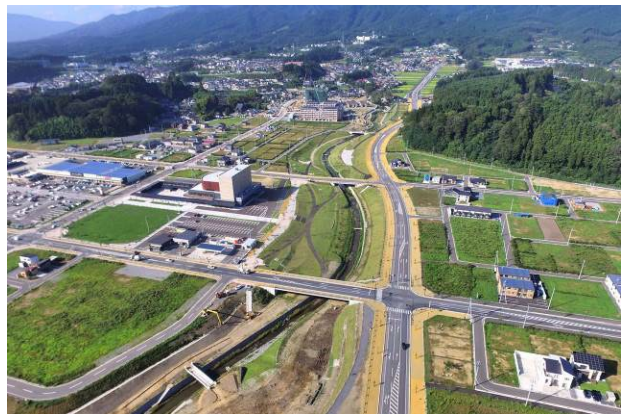
写真-1 嵩上げされた市街地を刻んで流れる川原川（施工中）。川の線形や河床高は震災前と変わらない。
