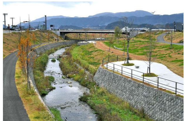
写真-14 緩やかな水辺，対岸に渡る潜り橋と階段，河岸緑地と川テラス，津波で流出した石材を使った石ベンチ
