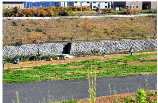
写真-15 石積護岸と階段，潜り橋，石ベンチ（津波流出材）
