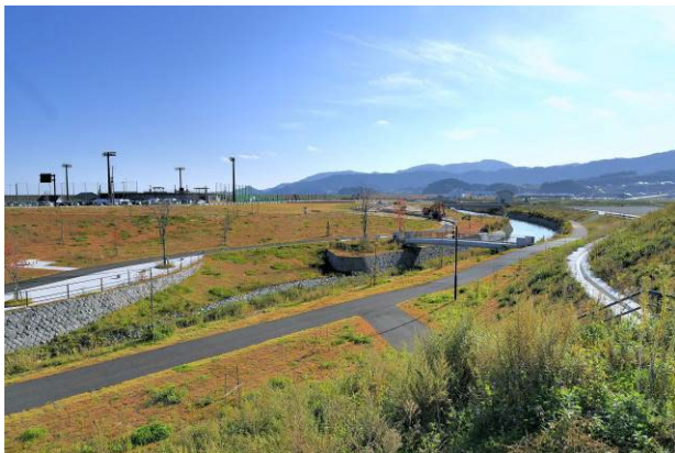
写真-12 護岸を入江状に分節して旧道の記憶を刻む。並木でルートサインとし、その先に踏み切り跡が保存されている。
