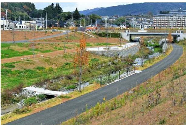
写真-16 歩行者を河岸から離れた位置に誘導する河畔緑地 (安全と景観を統合)。河岸法勾配変化点における文節デザインで川テラス空間を生み出す。変化のある河岸のリズム。
