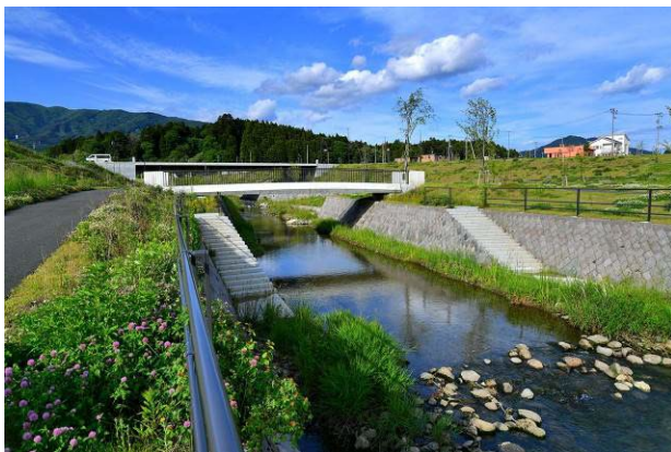
写真-13 人道橋（並杉橋）と早瀬式落差工（写真右下）
