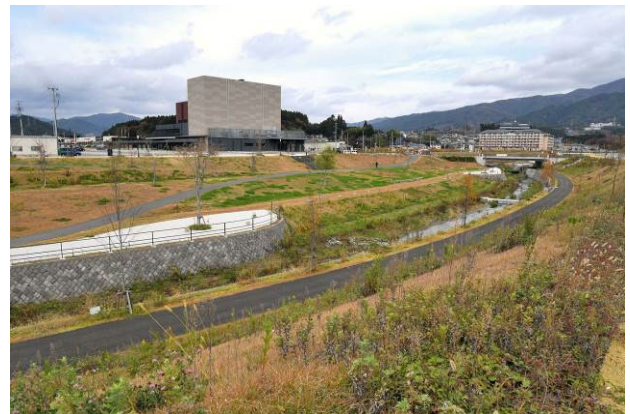
写真-5 にぎわいの水辺整備後：左建物は市民文化会館
