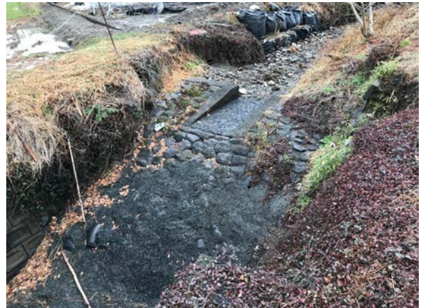
図-12 取水堰(コンクリートで被覆されている例はよく見られる)
