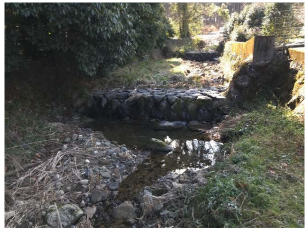
図-13 石造落差工
