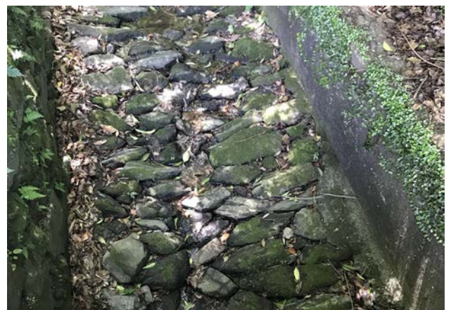
図-9 丁寧に石組みされた帯工（長）
