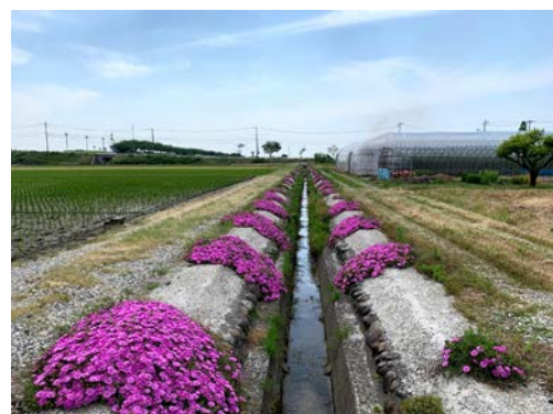
図-6 農地間を流れる植栽と石張を伴う三面張水路
