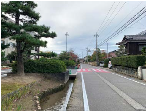
図-8 橋小学校前の模造木護岸とビオトープ
