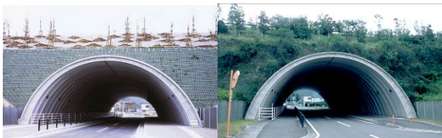
写真-11 県道カルバート付近の盛土 左: 2002年3月 右: 2007年9月
