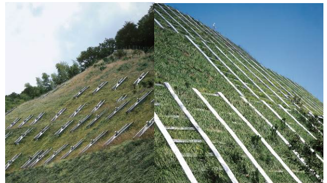
写真-4 新しいアンカー受圧板 写真-5 新しいのり枠工
