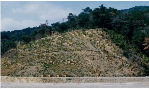
写真-16 上り線PAの傾斜を有する小段のり面 (2002年2月)
