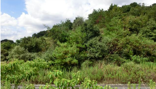
写真-17 上り線PAの傾斜を有する小段のり面 (2012年9月)
