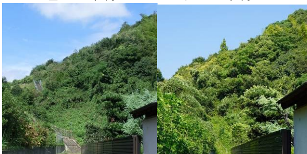
写真-10 大きなラウンディングのり面 左: 2012年9月 右: 2022年8月
