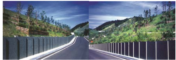
写真-2 盛土に採用された重ね合せ方式のL型擁壁
