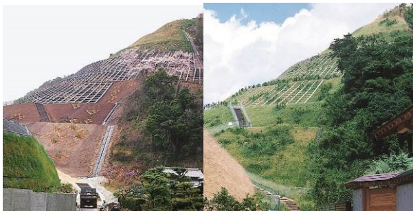
写真-9 大きなラウンディングのり面 左: 2002年3月 右: 2002年7月
