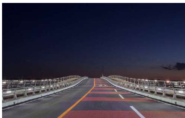
図-17 車道照明点灯状況
