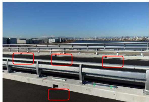
図-4 車道部の排水開口
