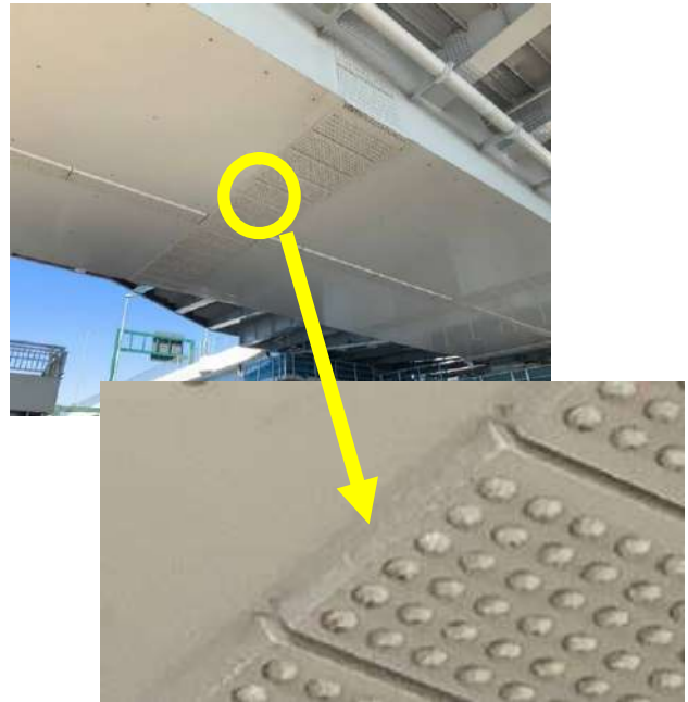
図-8 添接板面取状況
