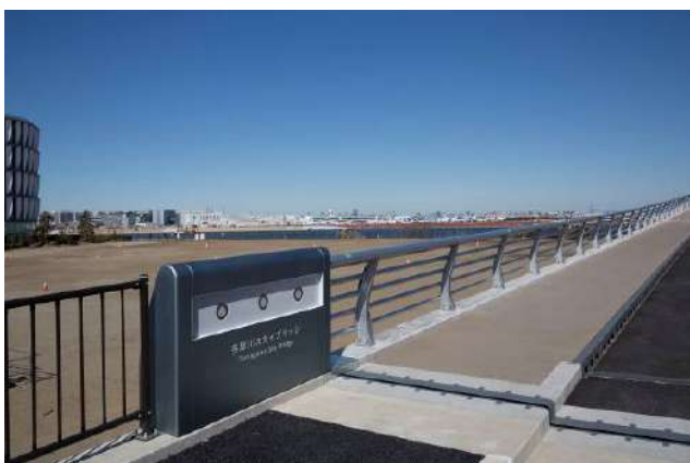
図-21 川崎側（右岸上流側）親柱
