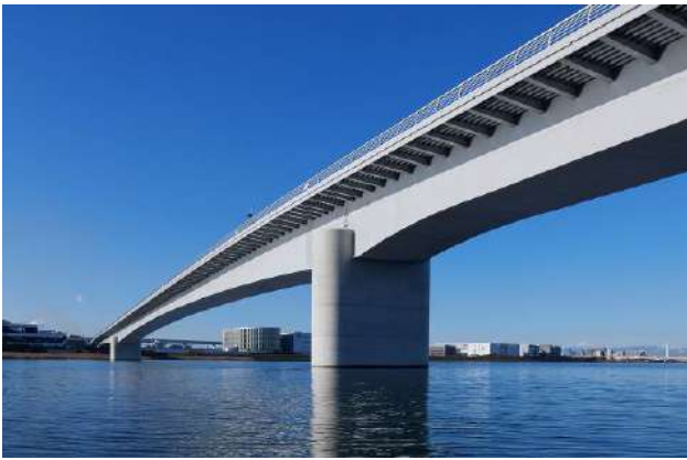
図-6 多摩川スカイブリッジ側面全景
