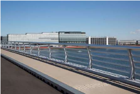
図-27 設置した高欄
