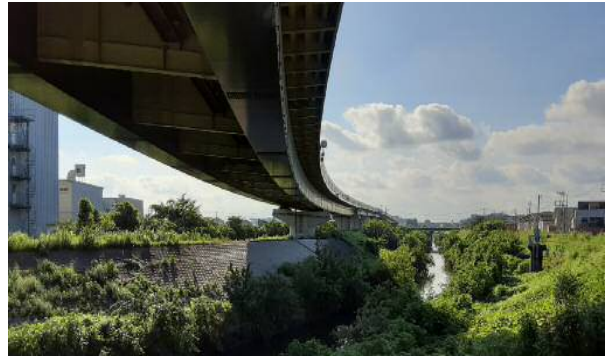
図-15 高架橋の風景（芝川交差点の堤防より眺める）（2022年8月）
