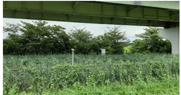
図-23 2006年開通から16年後の地下貯水槽を埋設した場所の高架下（2022年7月）
