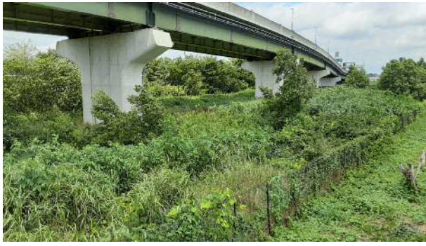
図-18 高架橋の風景（芝川堤防より眺める）（2022年7月）
