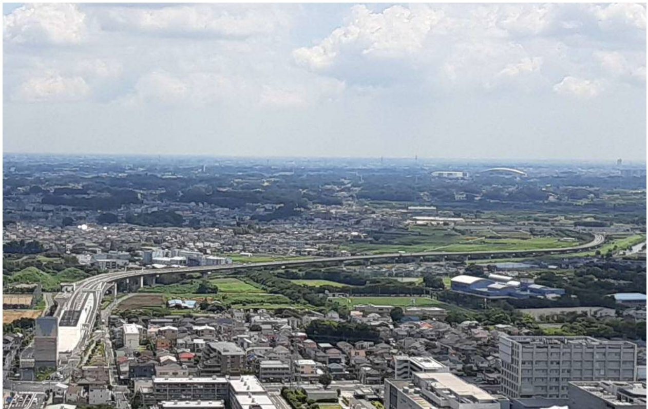
図-1 見沼たんぼの高架橋全景 (2022年8月)
