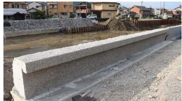
写真-11 パラペット施工状況 (右岸側)
