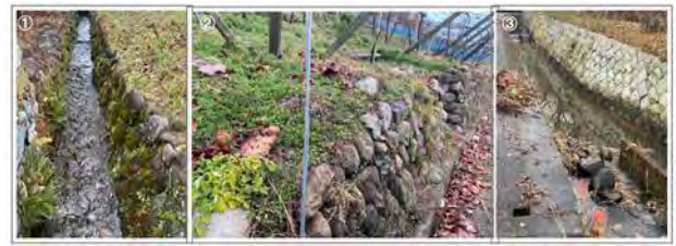
図-10 石積みの保全現状
