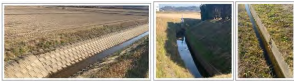
図-1 整備されたコンクリブロック護岸とU字水路工
