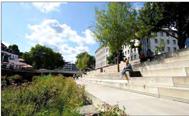
図-14 座りやすい段差高さの階段護岸
