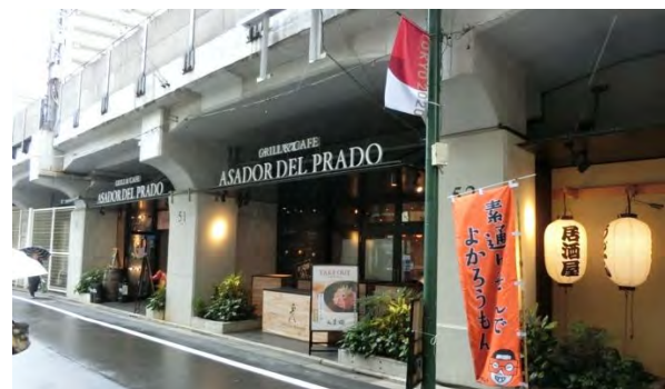
図-9 高架下と施設の隙間を塞いでいる事例（中目黒高架下）
