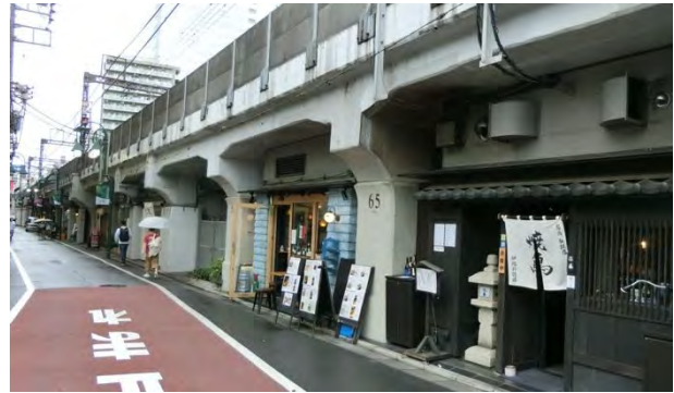
図-7 柱による反復を高架下の空間デザインに積極的に取り入れた事例（中目黒高架下）
