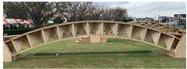
写真-11 可変式立体パネルトラス橋_側面形
