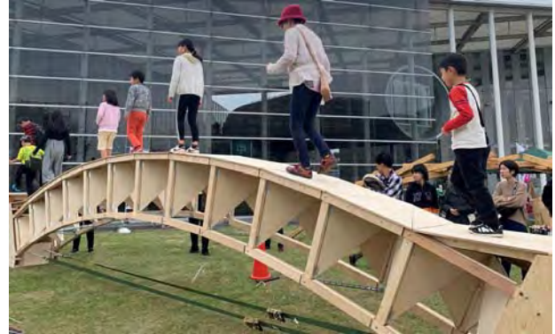
写真-12 可変式立体パネルトラス橋_イベント利用時
