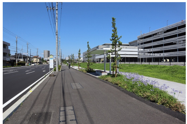
写真-11 競馬場通線完成写真
