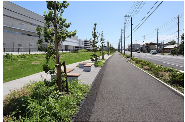
写真-10 競馬場通線完成写真
