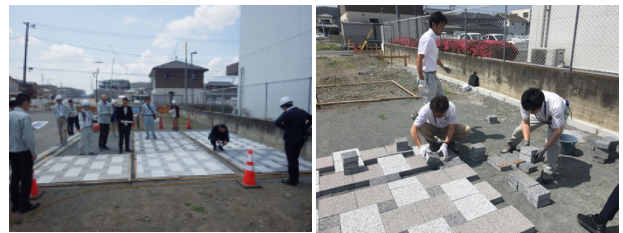
写真-1 舗装の現地確認
