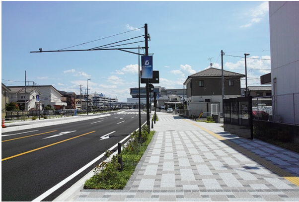
写真-8 北口線完成写真
