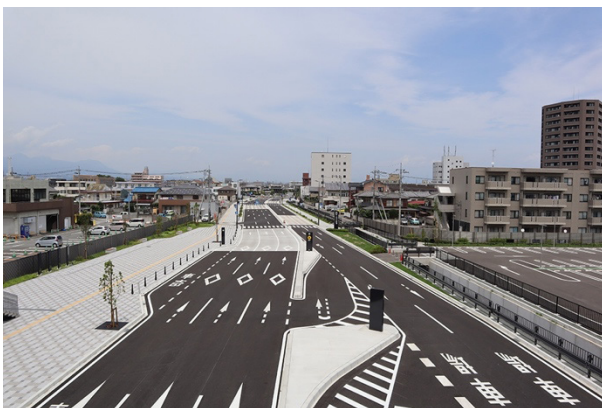
写真-9 北口線完成写真
