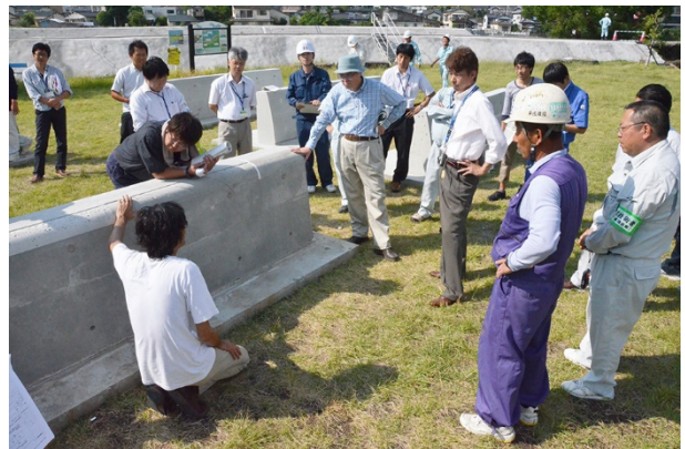
図-9 パラペットの試験施工による検討 (2013.10)
