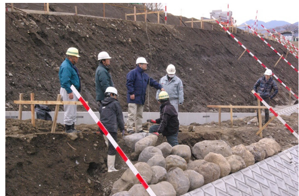
図-29 堤防水際に施工する石積みの現地確認 (2013.2)
