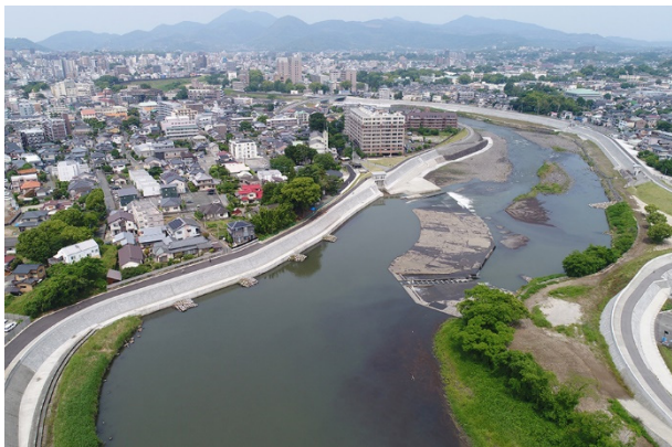
図-21 渡鹿堰上流から下流の眺め/⑦
