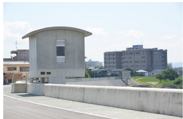
図-10 回遊動線沿いの柔らかなパラペットや樋管上屋の連続
