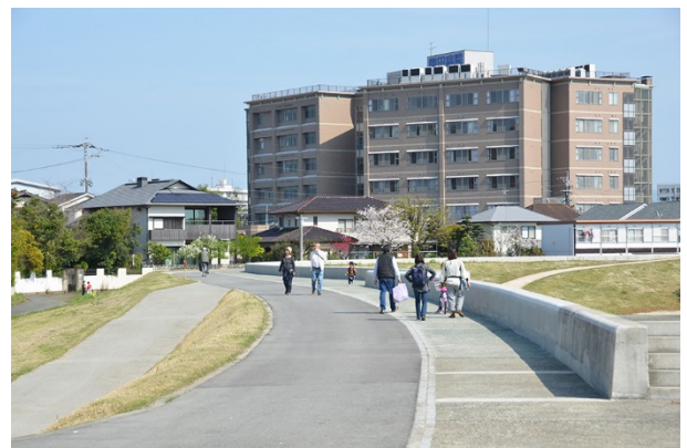
図-15 回遊動線となる管理用通路を利用する歩行者や自転車①
