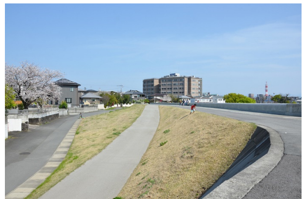
図-17 スロープや覆土によって川へのアクセス性も向上/③
