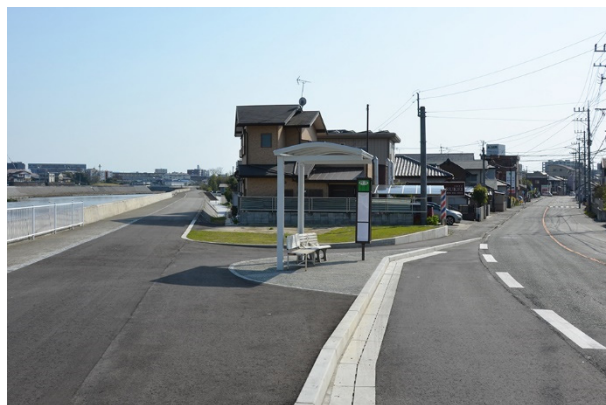
図-27 管理主体を超えて移設した整備後のバス停/⑫
