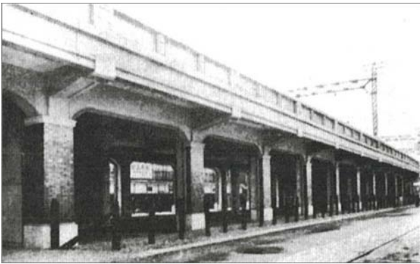
写真-1 阪神急行電鉄梅田高架橋(茶屋町付近)*
