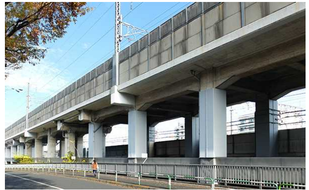
写真-2 直線ハンチ(赤羽駅付近高架橋)
