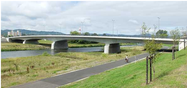
写真-5 連続桁(道路橋)の桁高変化(クリスタル橋)
