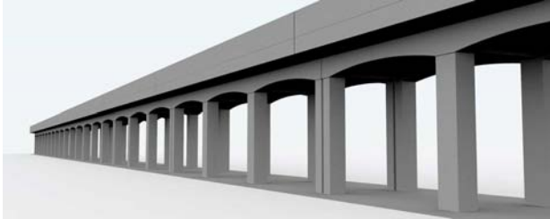
図-25 背割り式・曲線ハンチ(梁幅>柱幅)
