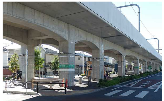
写真-3 曲線ハンチ(武蔵境駅付近高架橋)
