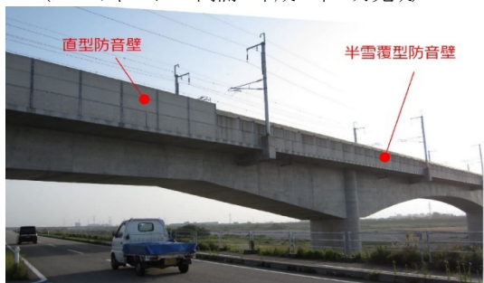
写真-5 北陸新幹線・庄川橋梁 (H鋼+PC板高欄・平成27年3月開業)
