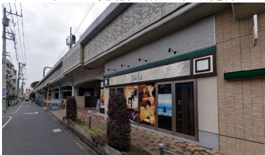
写真-8 小田急電鉄 梅が丘駅～豪徳寺駅間高架橋 (RC 高欄・平成 30 年 3 月完成)
