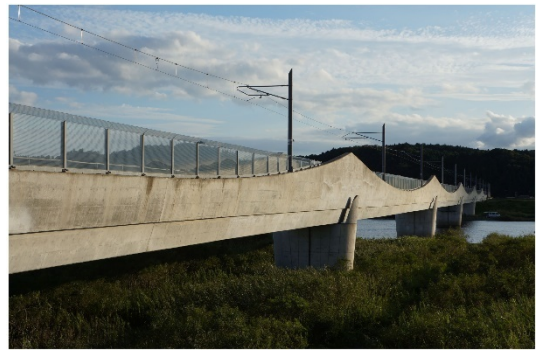
写真-11 JR 東日本 仙石線・鳴瀬川橋梁 (ナイロンコード入りアクリル板 平成 12 年 6 月完成)
