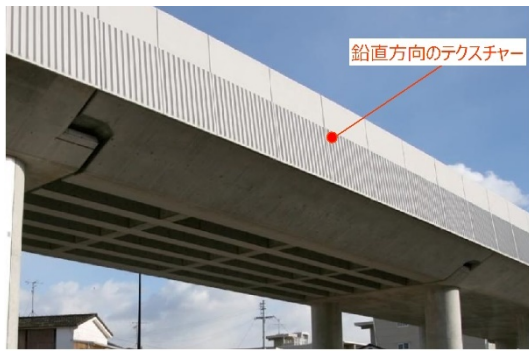
写真-6 JR 四国 土讃線・高知駅付近高架橋 (FRP 製高欄・平成 20 年 2 月完成)
