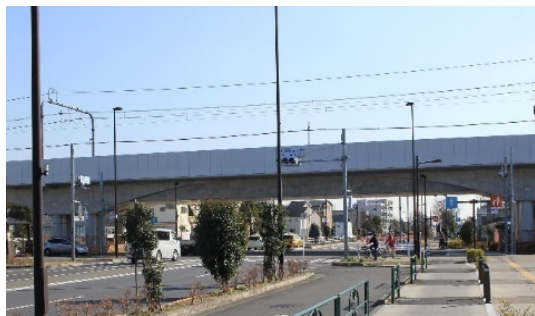
写真-1 JR東日本 中央線・武蔵境駅付近高架橋 (FRP高欄・平成22年11月高架完了)
