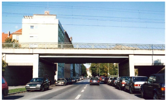
写真-12 ドイツ国 MVV 地方線のイザールタール通りと 交差する架道橋 (透明板)
