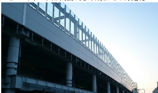
写真-10 相模鉄道・星川駅高架橋 (駅部は施工中) (強化ガラス 平成 30 年 11 月連立完成)
