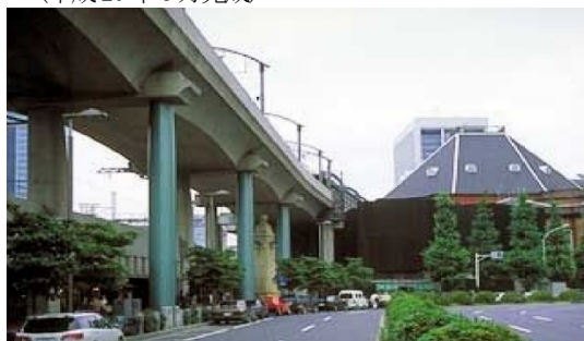
写真-4 JR東日本 中央線・東京駅付近高架橋 (プレキャストRC高欄・平成7年7月完成)
