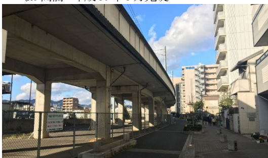
写真-9 JR 西日本 嵯峨野線 二条駅付近高架橋 (プレキャストRC 高欄+瓦 平成 20 年 5 月完成)
