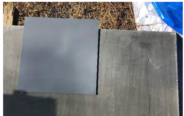
写真-5 塗装サンプルN4.5と埋設型枠
