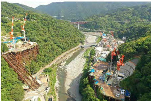
写真-1 河内川橋（仮称）上流側から見た工事現況
