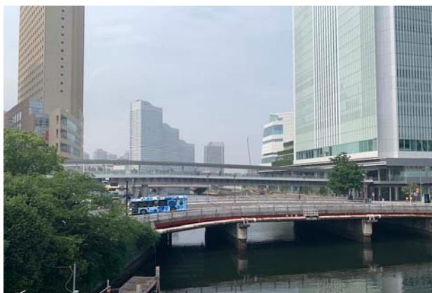
図-12 上流側から見たさくらみらい橋 手前に赤い橋は辨天橋、右側の高層ビルは横浜新市庁舎。奥にはMM21地区の高層ビル群が見える。
