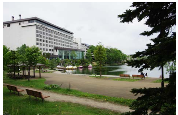
写真-1 本研究で対象とする屋外公共空間のイメージ(一例)
