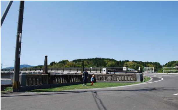
写真-10 ポケットパーク対象地B：右岸橋詰広場
