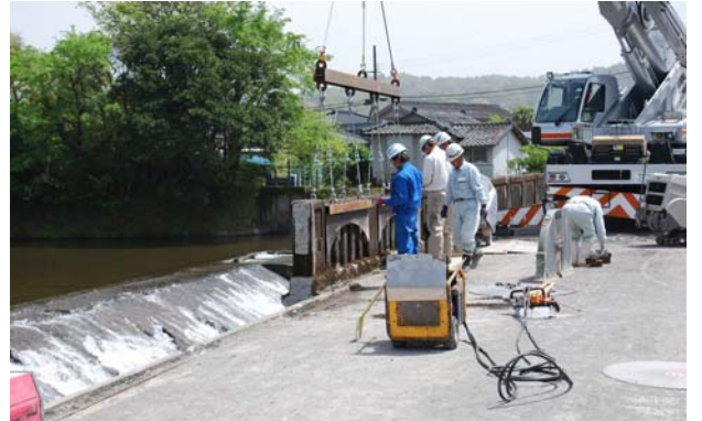
写真-13 高欄カットの施工状況
