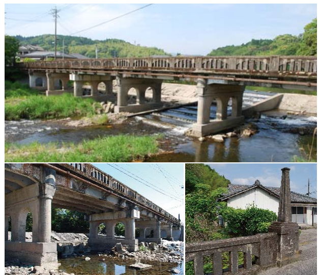
写真-1 山田橋の橋下と橋上
