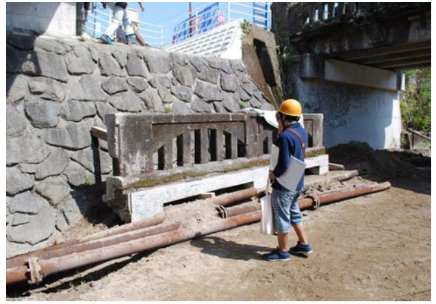
写真-12 一括カットした高欄ピースの例（タイプB）
