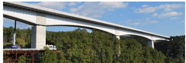
写真-1 第二東名高速道路赤淵川橋 (PC連続波形鋼板ウェブ桁橋, smcon.co.jp)
