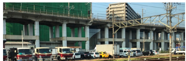
写真-2 山陽新幹線標準ラーメン高架橋 (ゲルバー式/広島県内, 筆者撮影)
