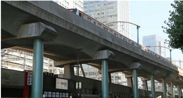
写真-3 中央線東京駅付近高架橋(筆者撮影)
