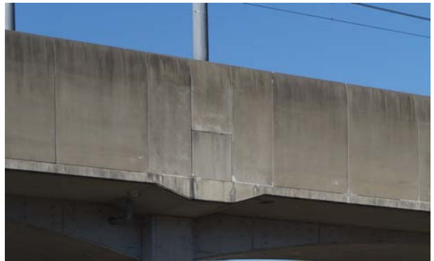
図-17 電柱支持梁
