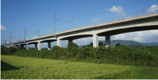
図-18 JR東北本線・平泉駅付近高架橋
