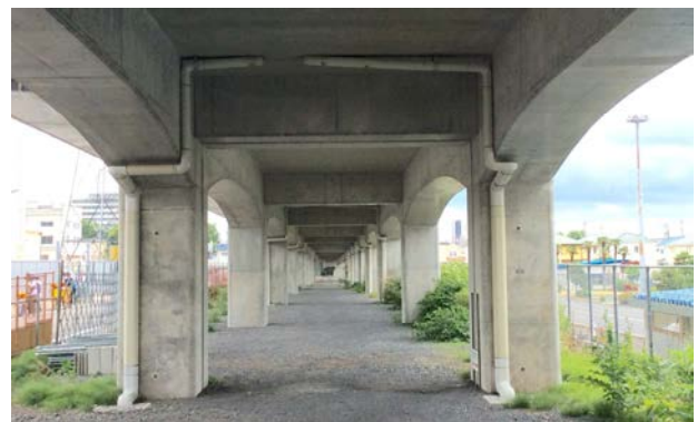
図-11 排水管の配置箇所
