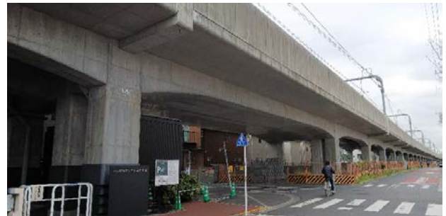
図-3 標準部高架橋
