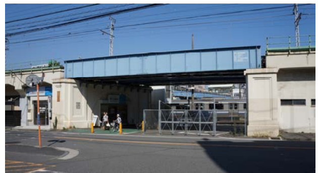
図-21 鶴見線・總持寺架道橋
