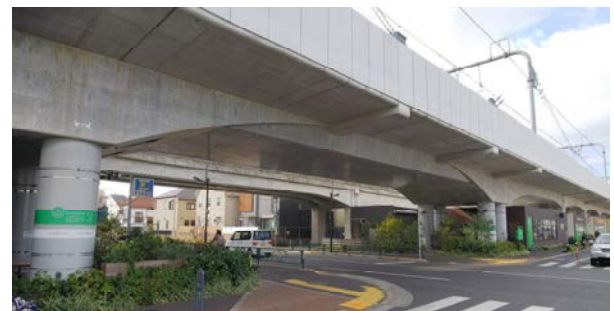
図-5 架道部・3径間連続PRCラーメン高架橋
