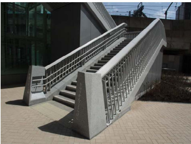
写真-4 高欄端部の収まり
