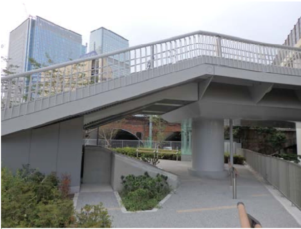
写真-1 通行可能な日本橋川沿いの桁下空間
