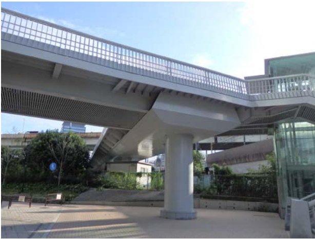
写真-3 箱桁と鉄桁の接続部
