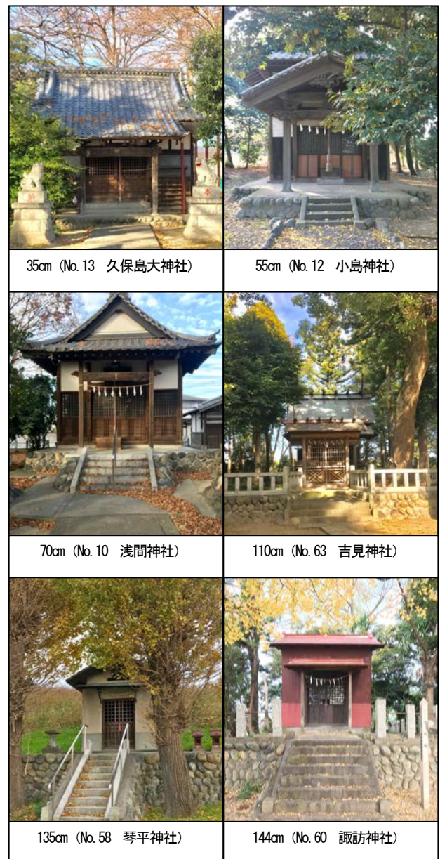
図-10 社殿の基礎の高さの例
