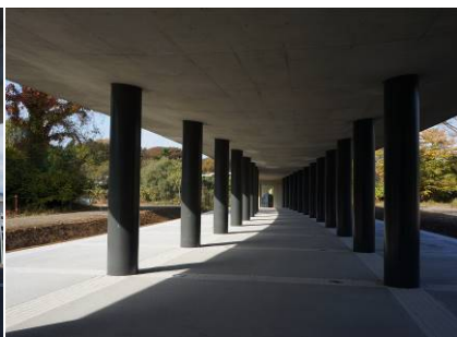
写真 15 仙台地下鉄東西線西公園高架橋
