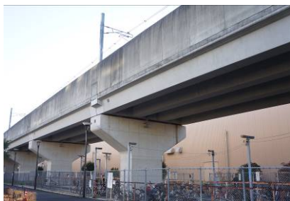
写真11 PCU形桁式高架橋、排水管は橋脚に
