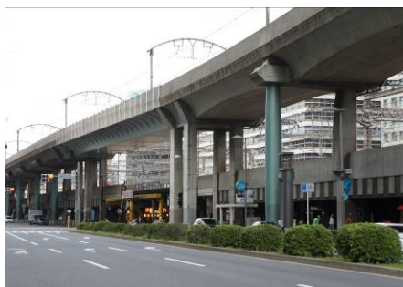
写真8 中央線東京駅付近高架橋
