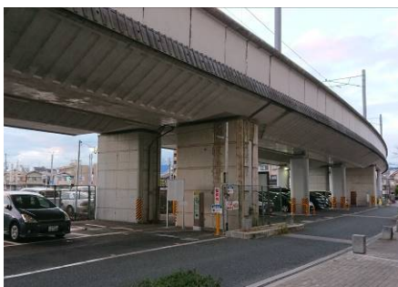
写真9 山陰線二条高架橋
