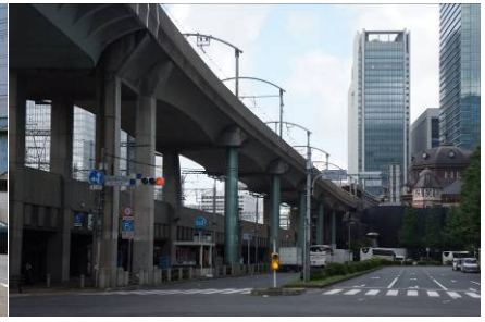
写真 22 駅舎と高架橋の関係
