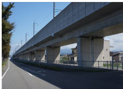
写真 14 北陸新幹線今村新田地区高架橋
