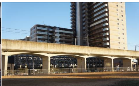
写真12 アーチスラブ式高架橋、排水管はスラブの側面から橋脚中に納められている
