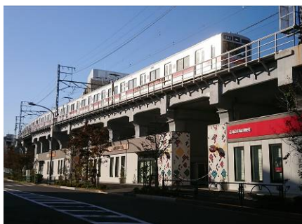
写真18 大井町高架橋、エクспанションがわからないほど統一感がある
