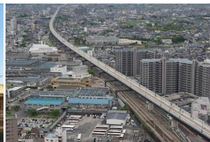
写真13 松原線路橋、1243mの直上高架橋 写真提供：JRIT
