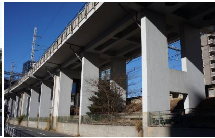
写真6 西品川1丁目付近の壁式高架橋
