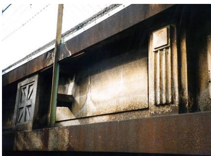
写真17 中津駅の高欄の装飾。人造石洗い出し仕上げを施している
