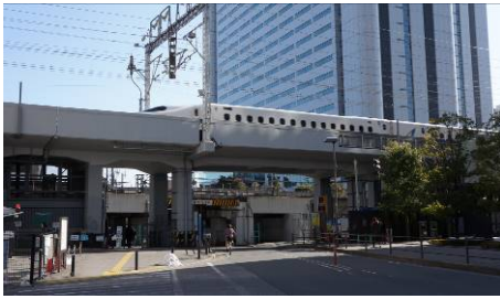
写真5 武蔵小杉駅付近のベタスラブ高架橋
