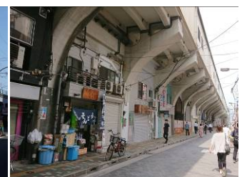
写真4 JR総武線浅草駅付近
