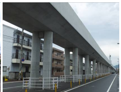
写真10 土讃線高知駅付近高架橋
