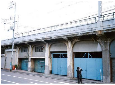
写真 20 5@5.5m標準部、張出部と電柱基礎の構造表現が素晴らしい
