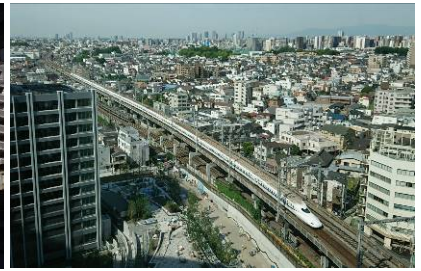
写真7 品鶴線（横須賀線）の直上高架橋
