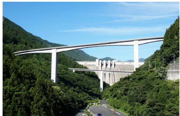
写真-1 雷電廿六木大橋と滝沢ダム(2018年8月)
