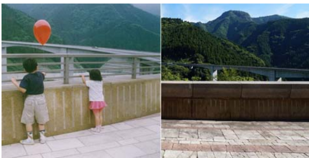
写真-18 右岸展望施設の状況(左: 1998年, 右: 2018年)
