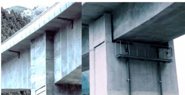
写真-12 排水管の横引き管 (1998年)
