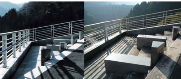
写真-17 左岸展望台の状況(左: 1998年, 右: 2018年)
