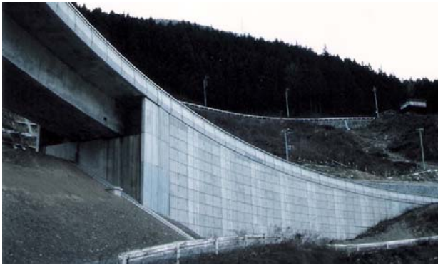
写真-10 補強土壁と緩やかな地形の埋戻し(1998年)
