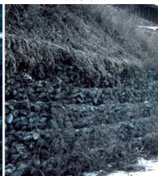
写真-9 仮設用道路のふとん籠 (1998年)
