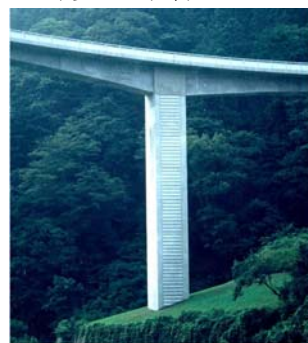
写真-8 橋脚基部の埋め戻し (1998年)
