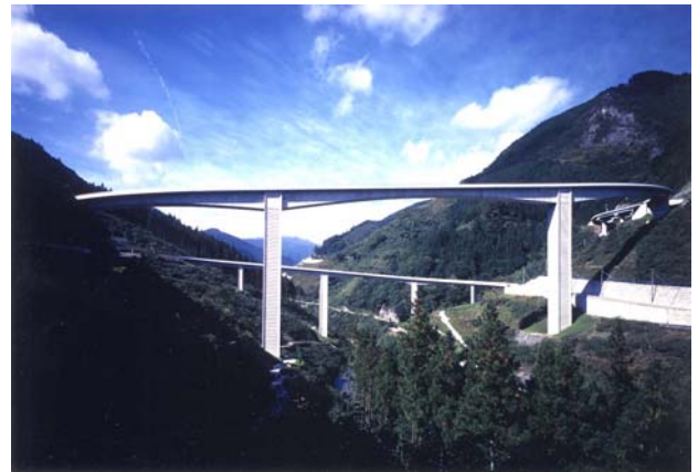
写真-2 ダムが未施工時の雷電甘六木橋(1998年)
