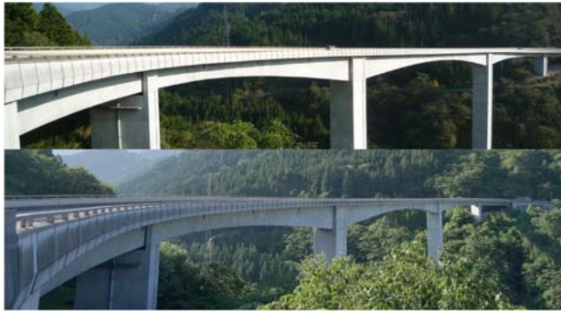
写真-21 主桁壁高欄のエイジング(上:2009年, 下:2018年)
