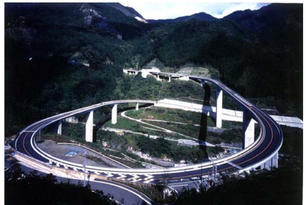
写真-3 ループ形状をした雷電甘六木橋(1998年)
