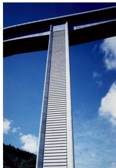
写真-7 橋脚デザイン(1998年)
