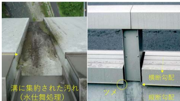
写真-6 笠木と溝に集約された壁高欄の水仕舞い (2009年)
