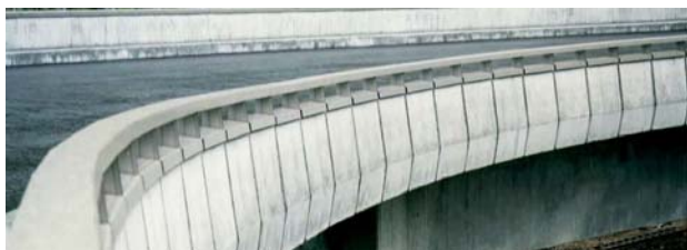
写真-5 主桁と壁高欄とアルミ製の笠木 (1998年)
