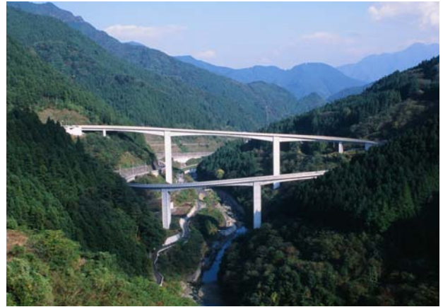
写真-14 滝沢ダム天端から雷電廿六木橋を眺める
