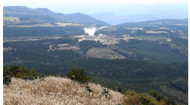
写真-1 遠景から白煙が目立つ地熱発電所の事例
