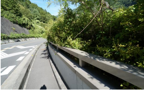
写真-6 土工区間の現状
