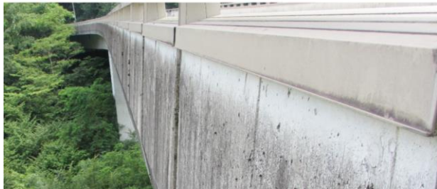
写真-7 ループ内側のP4橋脚からP3橋脚の壁高欄外面
