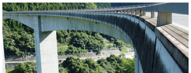
写真-5 P1橋脚からA1橋台の壁高欄外面
