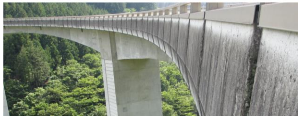
写真-8 ループ内側のP2橋脚からP1橋脚の壁高欄外面
