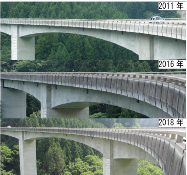
写真-10 ループ内側の北東～東側の方向を向く壁高欄
