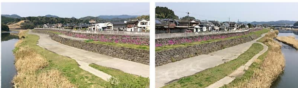
写真-23 宮之城橋の上下流約1kmに及ぶ芝桜護岸 (2018.3)
