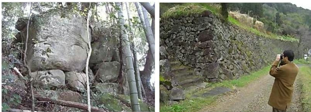
写真-6 虎居城跡の石積み 写真-7 薩摩興業跡の石積み
