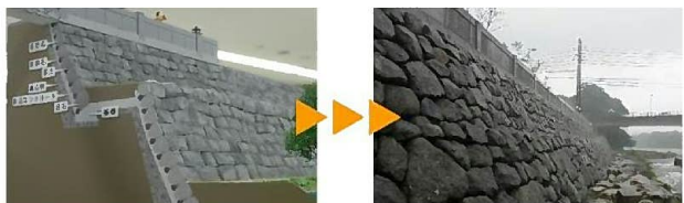
写真-11 石積み護岸工の比較（左：模型，右：現場）
