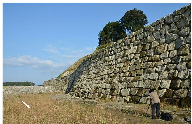
写真-5 推込分水路の直高9mの石積み護岸
