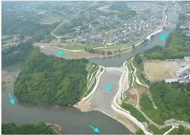
写真-9 推込分水路より整備区間全景（2011.5空撮）
