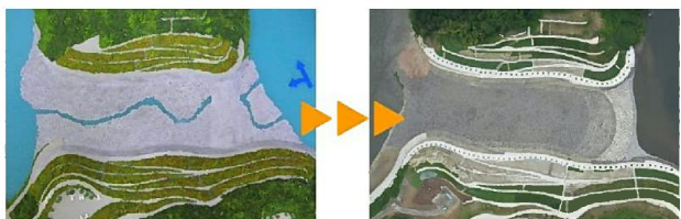
写真-12 推込分水路の比較（左：模型，右：現場）
