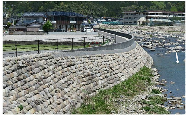
写真-3 花月川の石張り護岸（粒径φ400内外）
