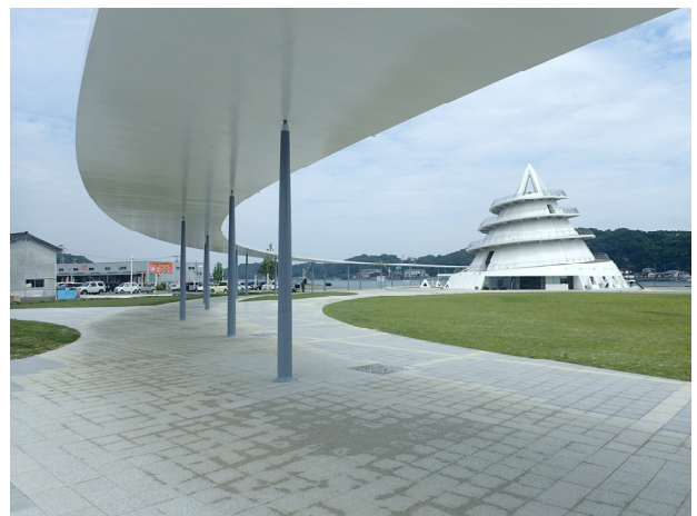
写真-5 栈橋へと誘導するキャノピー
