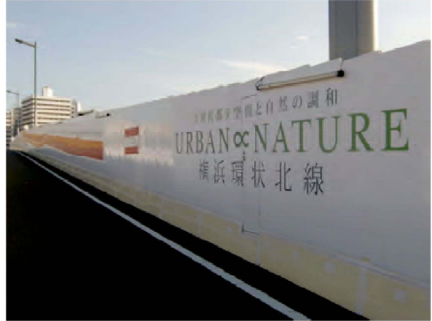
図-23 工事仮設物 (ベルコン仮囲い)
