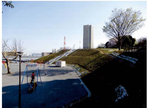
図-24 子安台換気所・子安台公園：学校のある住宅地に囲まれた子安台公園になじむデザイン
