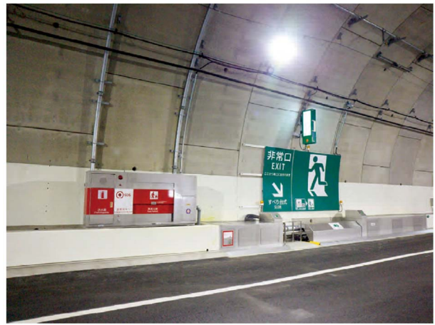
図-28 トンネル内部空間：機能を集約した施設配置と空間デザインによる、安全で快適なドライブを引き出す次世代のトンネル走行空間の実現 トンネル非常口誘導サイン：非常時の遠方・近接の歩行者からの見え方に配慮した高さ・形状・色
