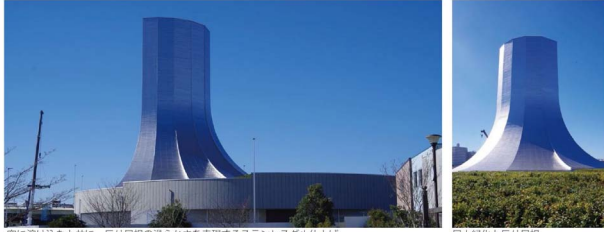
空に溶け込むと共に、反り屋根の滑らかさを表現するステンレス仕上げ
