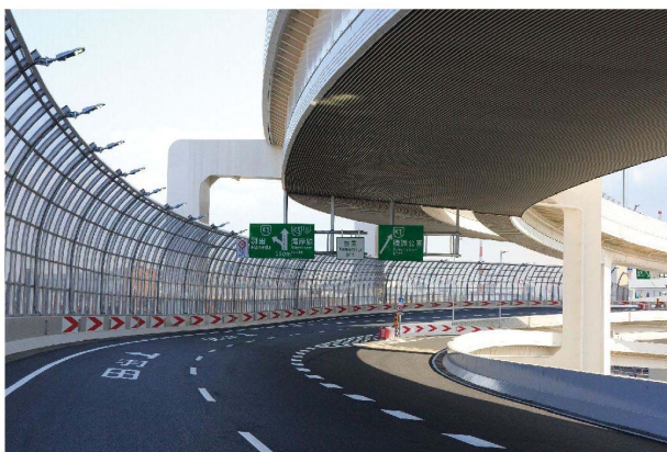
図-16 生麦高架橋内部景観
