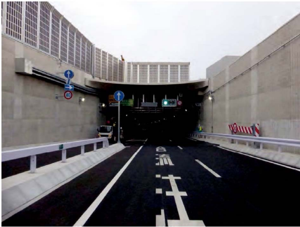
図-25 新横浜トンネル坑口：坑口形状、遮音壁使用による進入抵抗感の緩和
