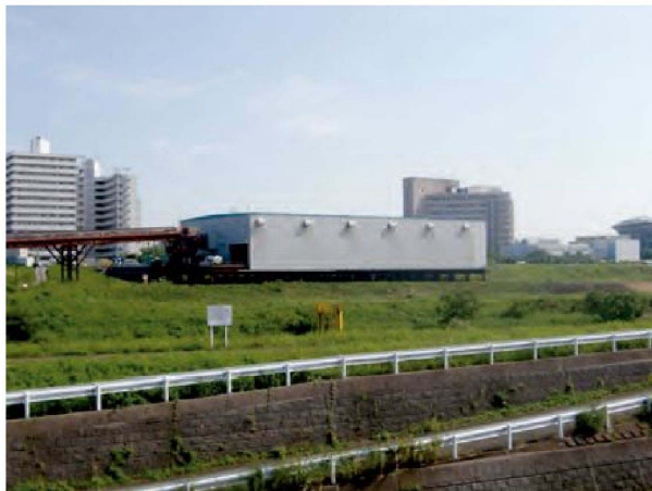
図-22 工事仮設物 (防音ハウス)
