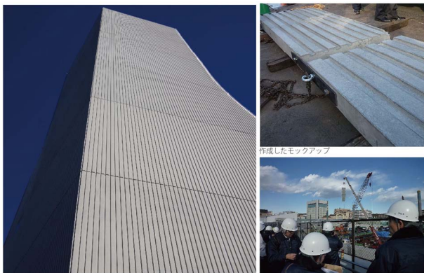
シンプルなスリット仕上げ
